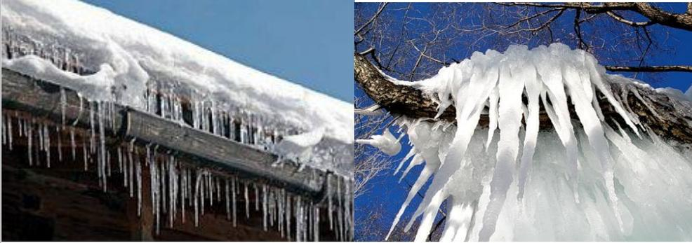
**ПРОБЛЕМА.** Зимой на зданиях, водосточных желобах и крае кровли образуется наледь и сосульки. Причина такого обледенения - потеря зданием тепла и перепады температуры. Возникающая в результате талая вода не может стечь и замерзает.
